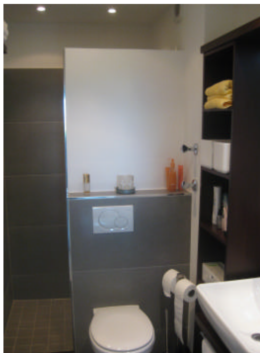
Nasszelle nach Umbau
