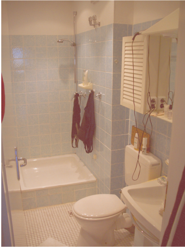
Nasszelle vor Umbau
