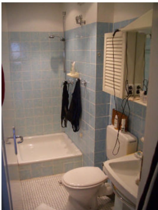
Nasszelle vor Umbau
